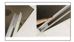
8. Schieben Sie die Verriegelungsklammern von innen unter die Köpfe der M4-Schrauben.
