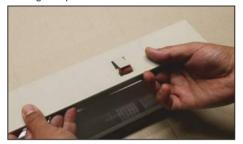
7.Setzen Sie die Leuchte von unten in den Montageadapter ein. Drücken Sie während dieser Manipulation nicht auf den Kunststoffdiffusor!
