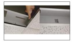
9. Ziehen Sie nach dem Einsetzen der Verriegelungsklammern die Schrauben fest.
