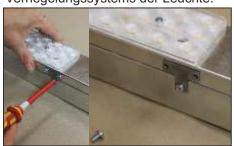
4. Montagemethode: Schrauben für die Aufbaumontage oder Aufhängen mit einer Kette.
